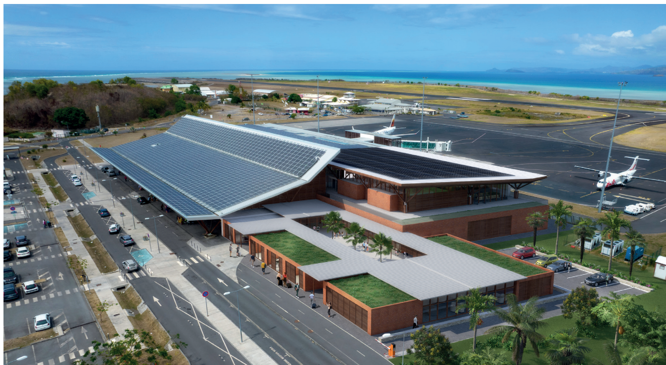
Photo Aérogare de Mayotte – Edeis ingénierie en charge des travaux d'extension de l'aérogare de l'aéroport de Mayotte Marcel Henry
