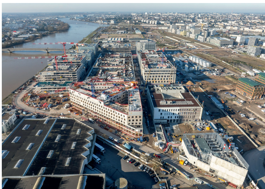
Photo du chantier du nouvel hôpital de Nantes, le plus grand chantier hospitalier d'Europe - Edeis ingénierie, Patriarche et Builders & Partners, maître d'œuvre d'exécution
